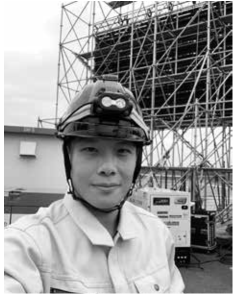
大型LEDパネルの設置作業中
