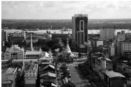
開発が進むヤンゴン市内
